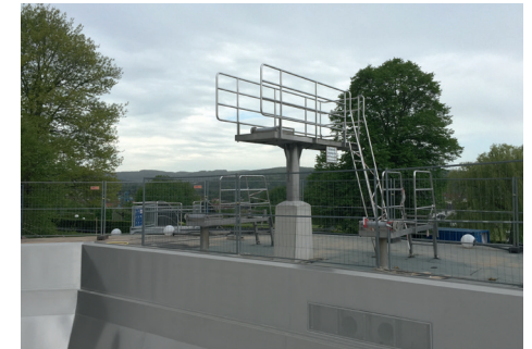
Das neue Edelstahlbecken mit Sprungturm
